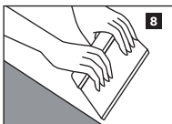
Покрытие укладывается на подсушенный клеевой слой (время подсушки указано на этикетке). Приклеенный участок необходимо прикатать, например, притирочной доской.
