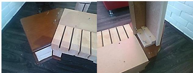
2. К колоннам прикрепить три шторки в зависимости от устанавливаемого очага, совмещая отверстия и закрепить винтами барашек 20мм (см. фото)
