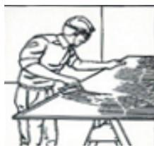
Резка панелей ножовкой производится с лицевой стороны, циркулярной пилой – с изнанки. Размер панелей должен быть меньше от пола до потолка на 1 см, чтобы оставить зазор для расширения.
