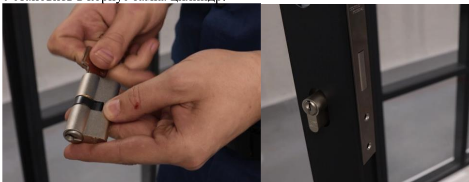
Затянуть замок винтом М5х40 из комплекта, предварительно рассверлив отверстия сверлом
