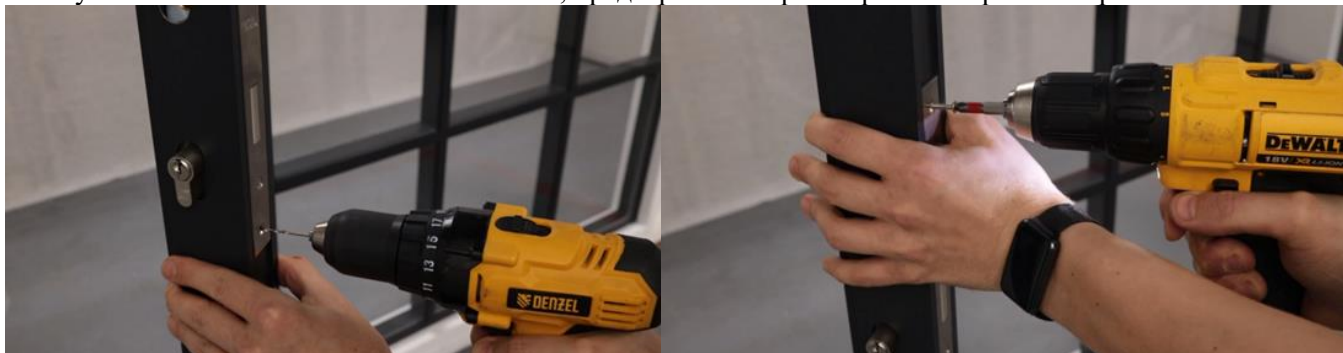
Закрепить накладку на цилиндр саморезами, предварительно разметив и рассверлив отверстия
